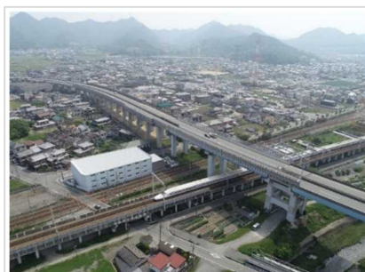
【播但道 新幹線大橋】
