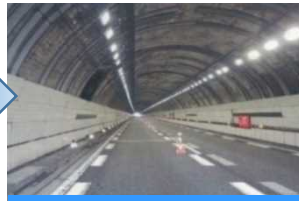
【トンネル照明LED化】
