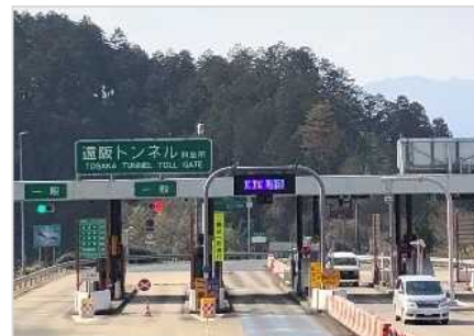
【遠阪トンネル 料金所】
