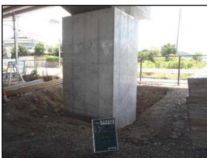
【対策事例：橋脚補強】
