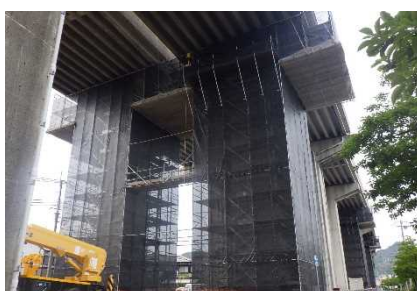
【第8高架橋施工状況（R5.6）】
