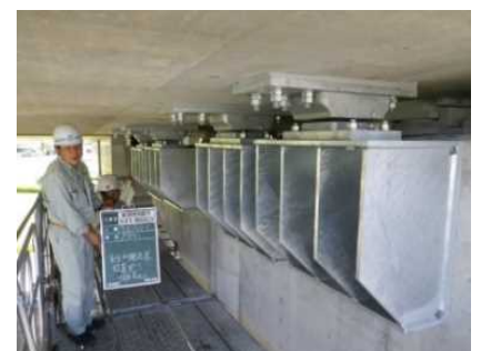
【対策事例：支承部の補強】
