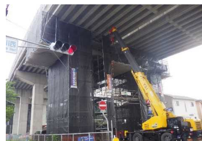
【第8高架橋施工状況（R5.6）】
